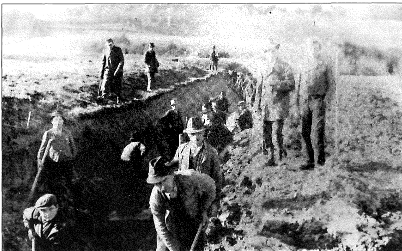
Bau eines Panzergrabens, Heiligenbrunn 1945
