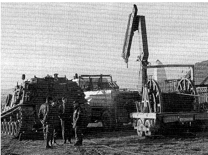
Mit diesem Spezialgerät wurde ein Informationskabel durch den Neusiedler See gelegt. Nachdem dieses Gerät im Schlamm stecken geblieben ist, mußte ein Bergepanzer des Bundesheeres zu Hilfe geholt werden.
