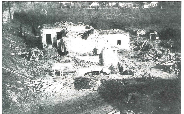
Durch Fliegerbomben zerstörtes Haus in Güssing
