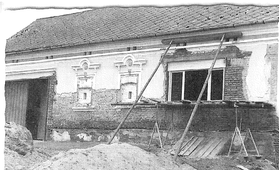
Umbau einer Hausfassade, Eisenhüttl 1968
