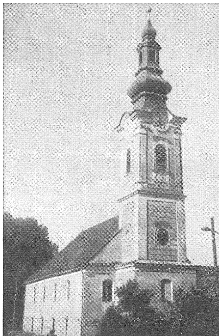
Evang. Kirche zu Kukmirn (im alten Bauzustand)
