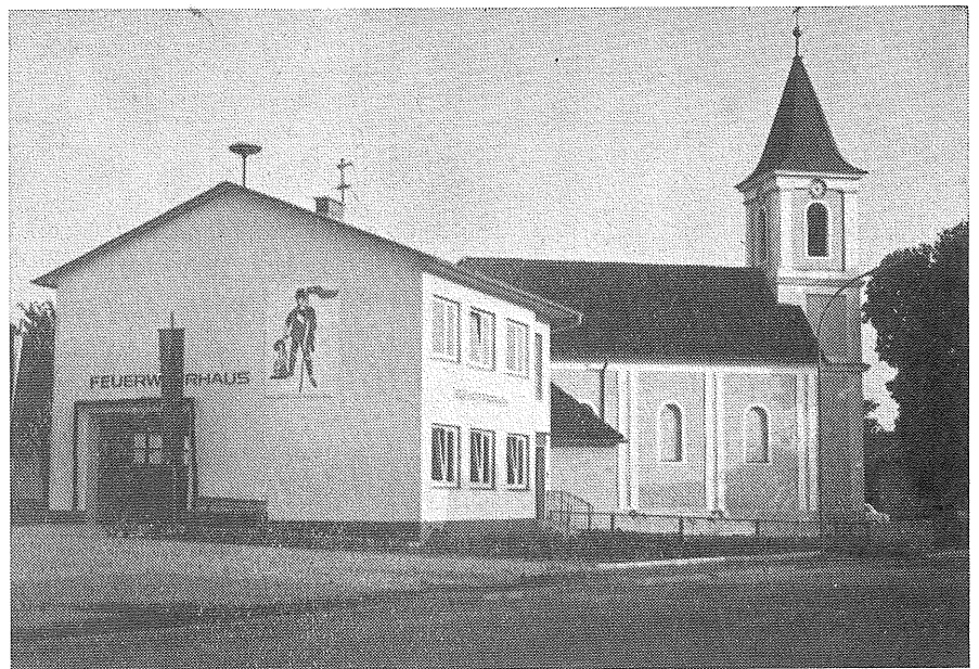
Das neue Feuerwehrgerätehaus in Tobaj
