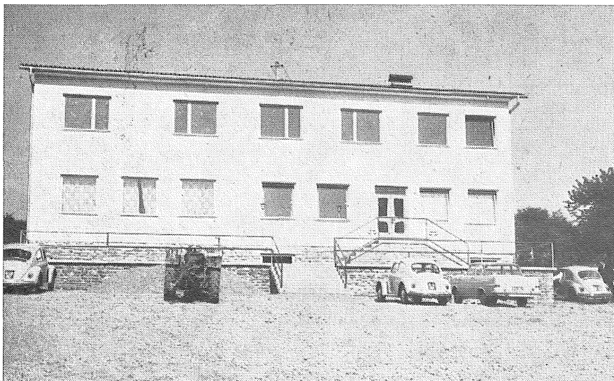
Johann Gober aus Deutsch-Ehrendorf errichtete in seiner Heimatgemeinde einen modernen Gaststättenbetrieb mit Fremdenzimmern. Johann Gober war lange Zeit in USA.
