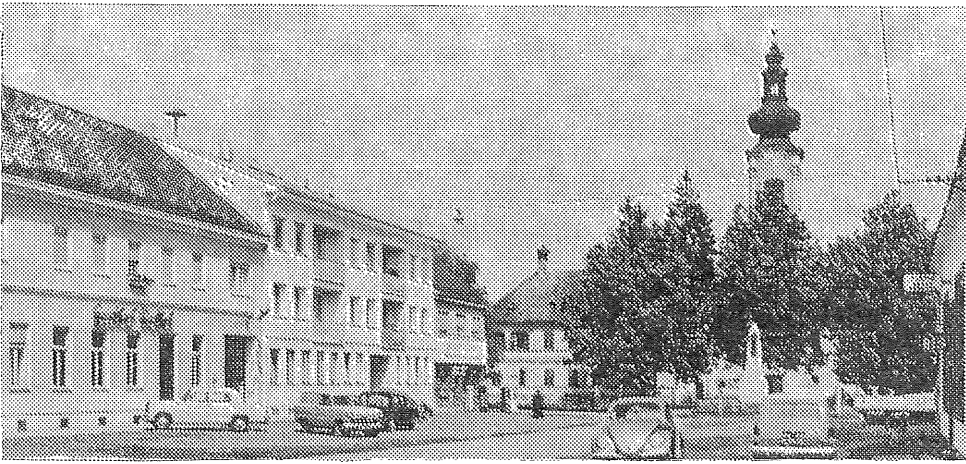
JENNERSDORF — Der Hauptplatz erhielt ein imposantes, modernes Gesicht durch den großartigen Zubau zum Hotel-Restaurant Raffel (Ernst Kampel).
